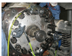
Kết hợp đai ốc HYTORC tiến hành siết kéo căng dọc trục không bị lệch tải.
