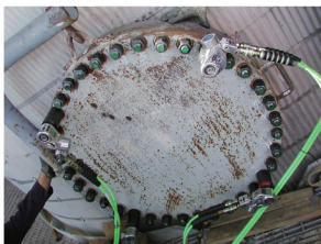
Mặt bích của Nhà máy luyện dầu, 4 bước đồng bộ AVANTI-3 gồm siết căng, nhanh, an toàn, tin cậy
