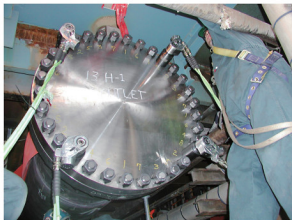
Siết bu lông mặt bích đầu vào của thiết bị trao đổi nhiệt trong nhà máy hóa dầu, đường kính bu lông 1-5/8", 4 bước đồng bộ AVANTI-3 gồm chặt, nhanh, an toàn, tin cậy
